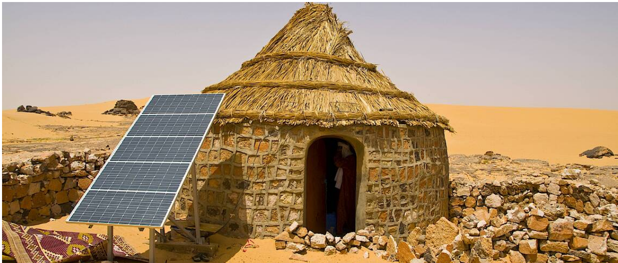
Konstruktiver Gegensatz: Solarzellen in Algerien
